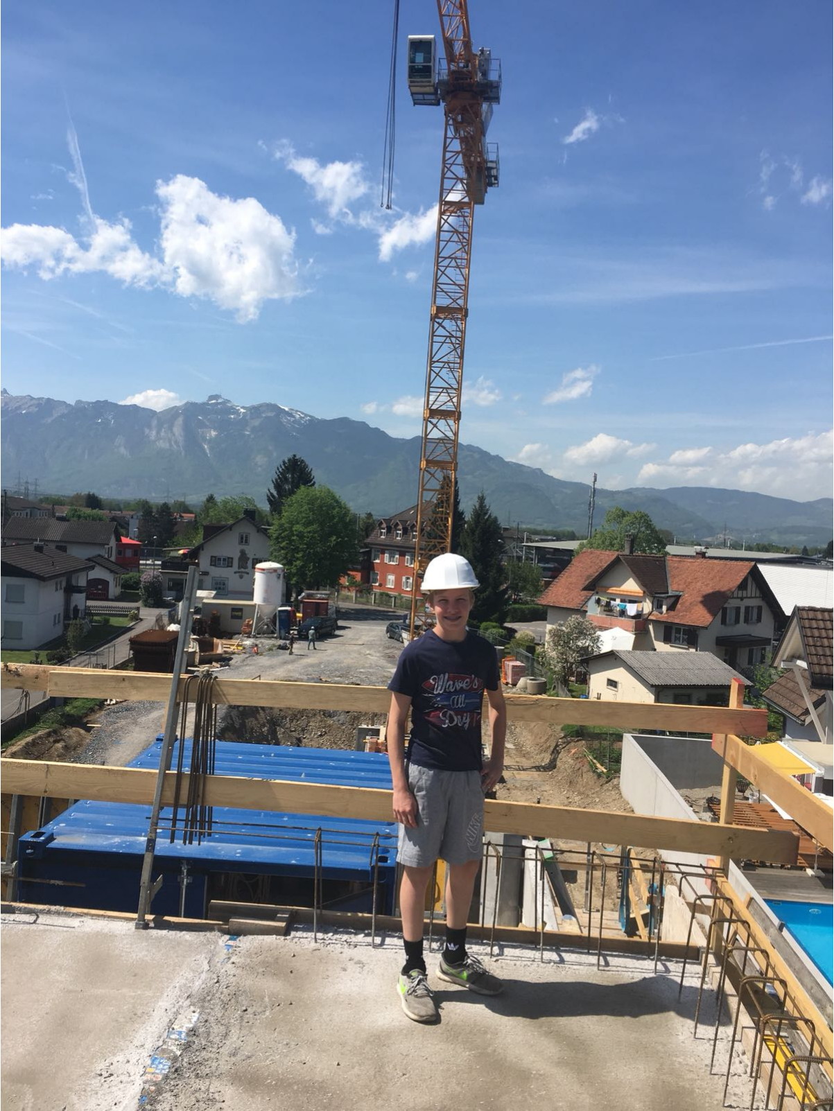
Baustelle in Rankweil nahe Bahnhof
